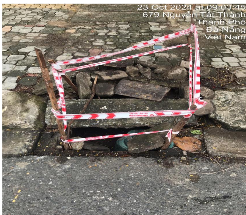
Hình ảnh trước xử lý cửa thu nước hư hỏng tại 631 đường Nguyễn Tất Thành
