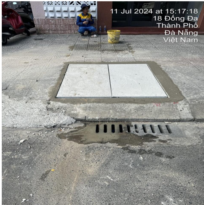
Hình ảnh sau xử lý hố ga thoát nước trên đường Đống Đa
