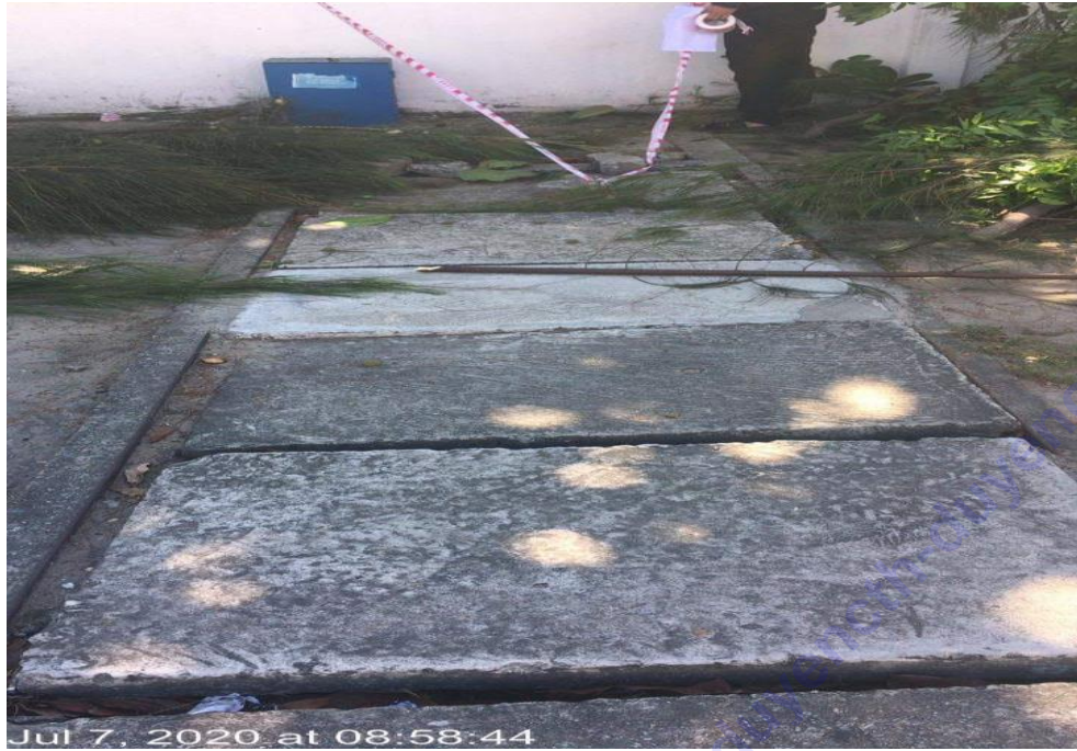
Hình ảnh trước xử lý vị trí đan hờ tại số 2 đường Yết Kiêu
