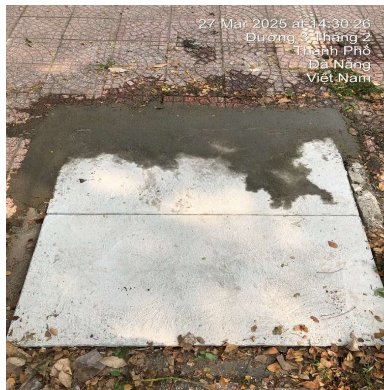
Hình ảnh sau xử lý nắp hố ga gần số nhà 98 đường 3 tháng 2
