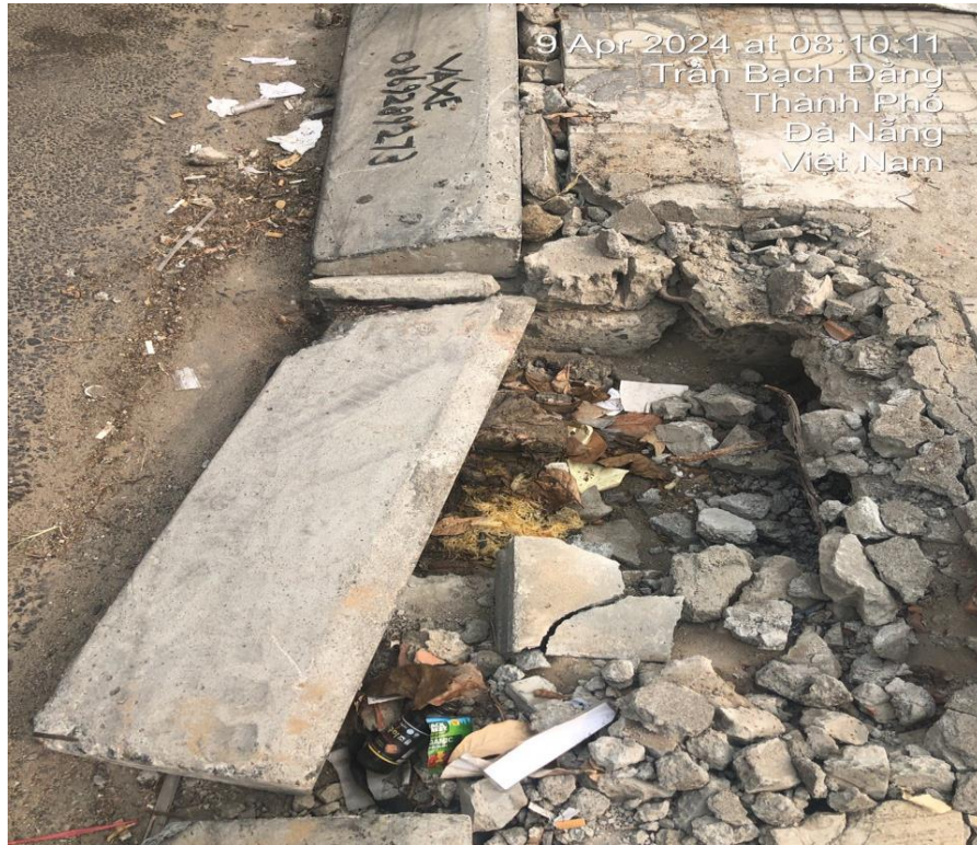
Hình ảnh trước xử lý bó vỉa trên vỉa hè đối diện số 132 Trần Bạch Đằng
