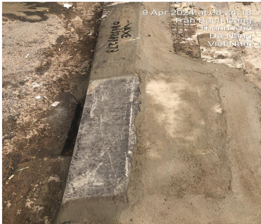
Hình ảnh sau xử lý bó vỉa trên vỉa hè đối diện số 132 Trần Bạch Đằng
