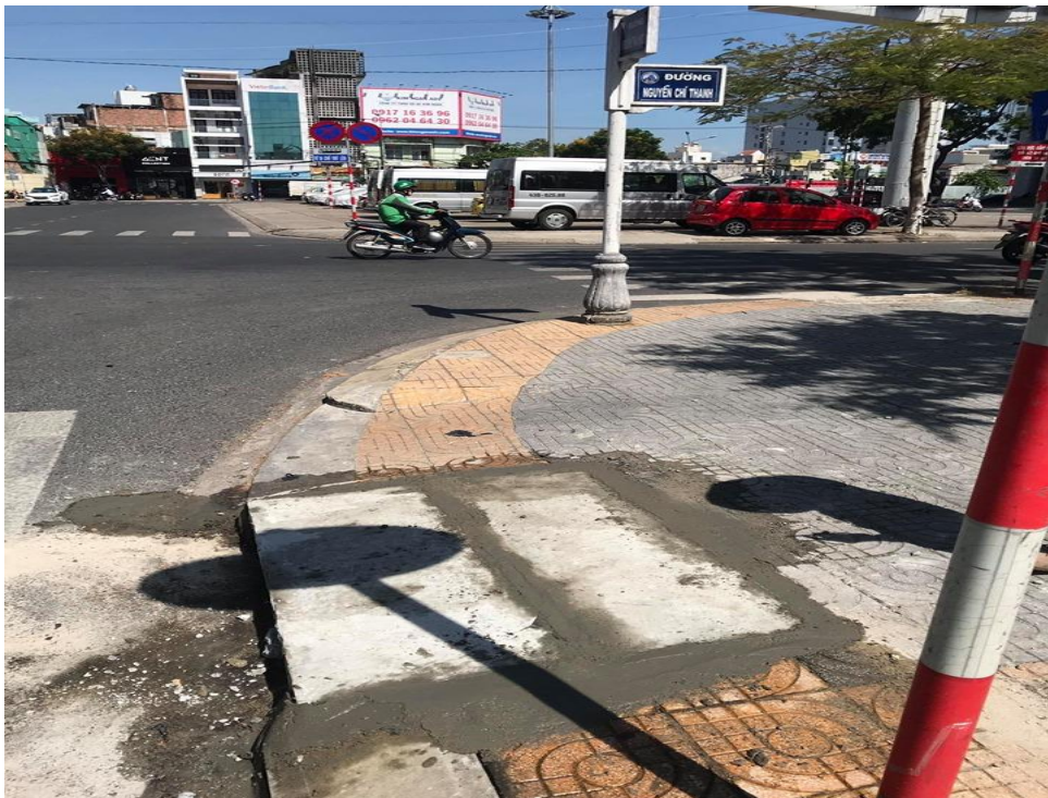
Hình ảnh sau xử lý tại nắp cống bị vỡ góc đường Nguyễn Thái Học – Nguyễn Chí Thanh
