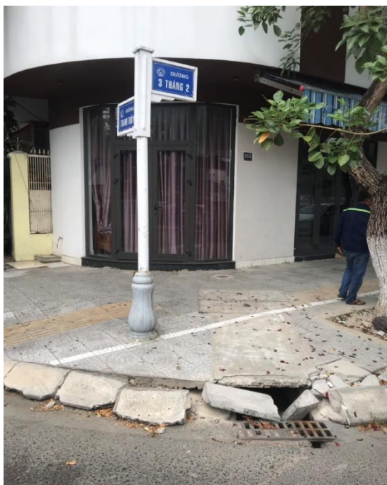
Hình ảnh trước và sau xử lý bó vỉa hỏng tại ngã ba tuyến đường Thanh Thủy – 3 Tháng 2
