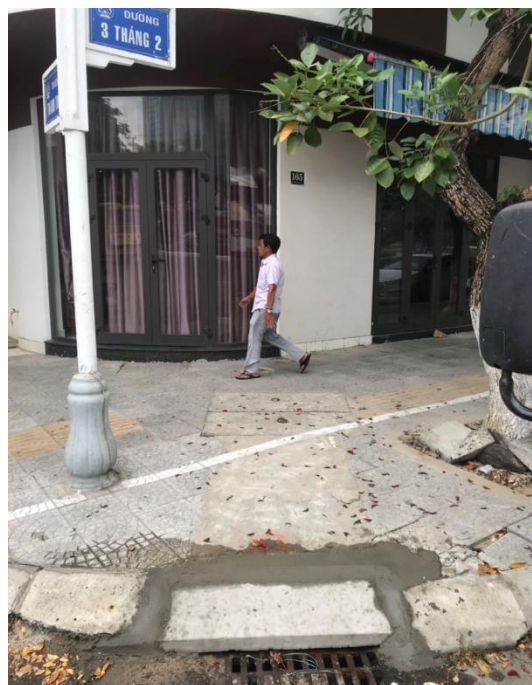
Hình ảnh trước và sau xử lý bó vỉa hỏng tại ngã ba tuyến đường Thanh Thủy – 3 Tháng 2
