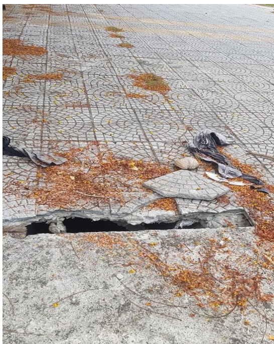
Hình ảnh trước và sau xử lý tại nắp cống bị vỡ trên đường Hoàng Sa
