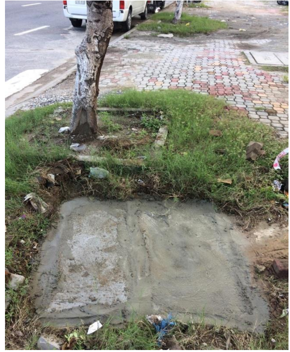
Hình ảnh trước và sau xử lý hư hỏng công trước số nhà 1251 Nguyễn Tất Thành
