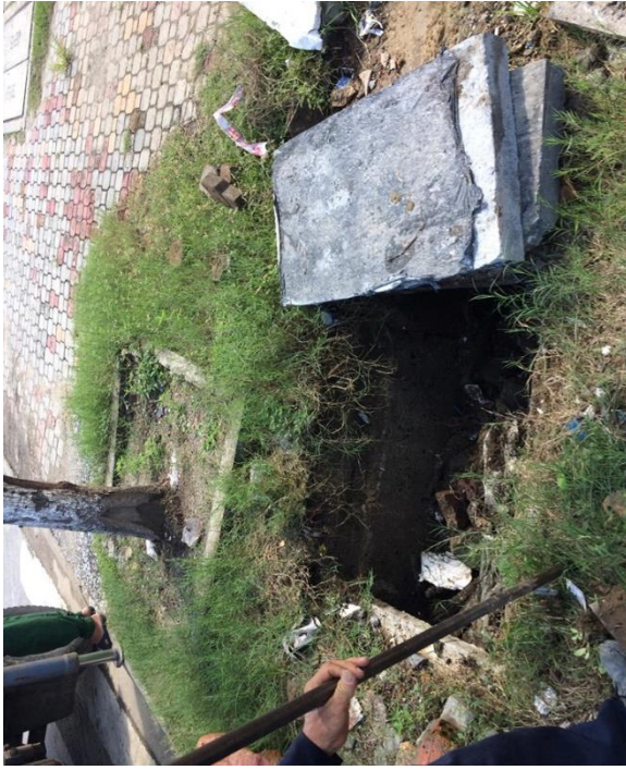
Hình ảnh trước và sau xử lý hư hỏng công trước số nhà 1251 Nguyễn Tất Thành
