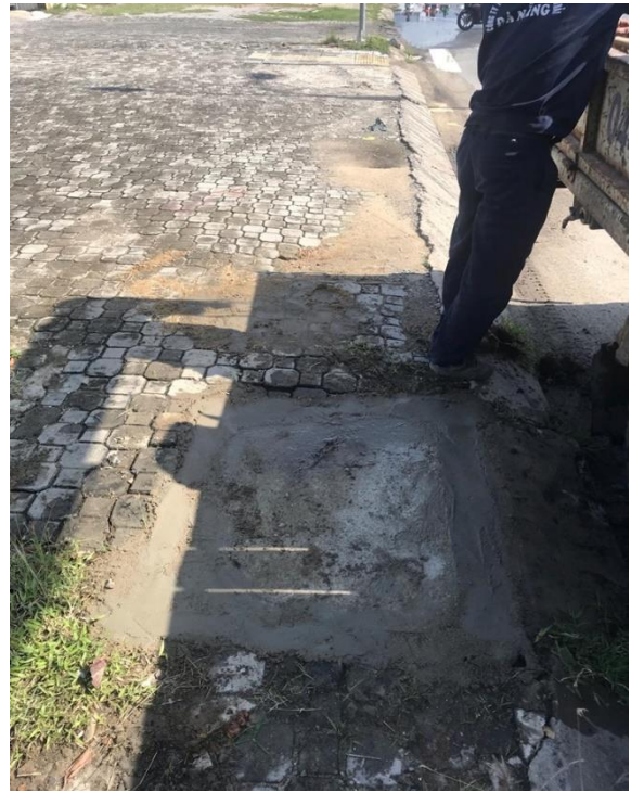
Hình ảnh trước và sau xử lý vỉa hè sụt lún đối diện KS Công đoàn
