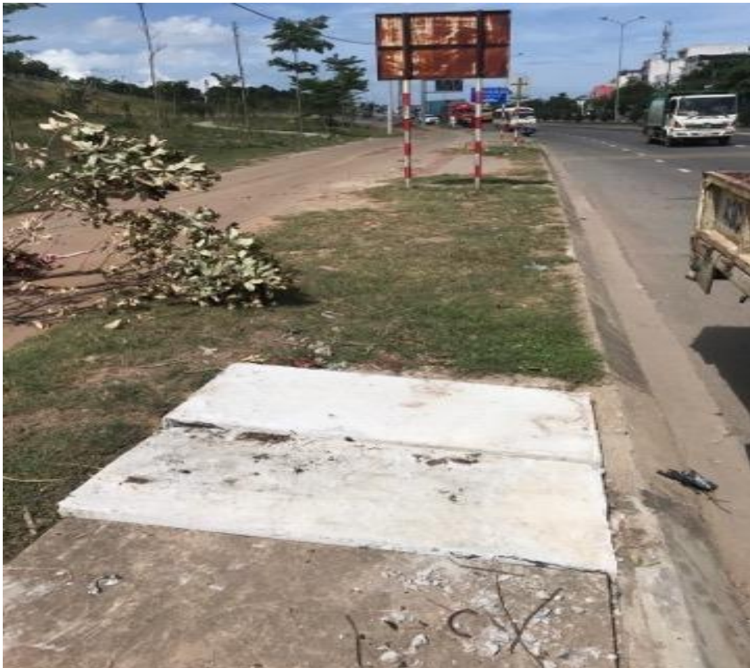
Hình ảnh sau xử lý tại vị trí hư hỏng trên đường Trường Sơn
