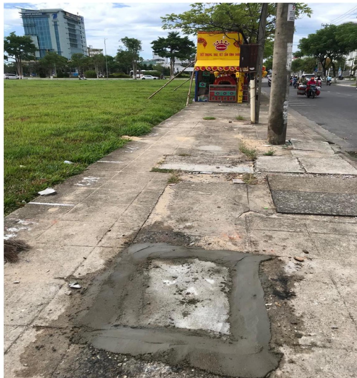
Hình ảnh sau xử lý tại công trường Núi Thành
