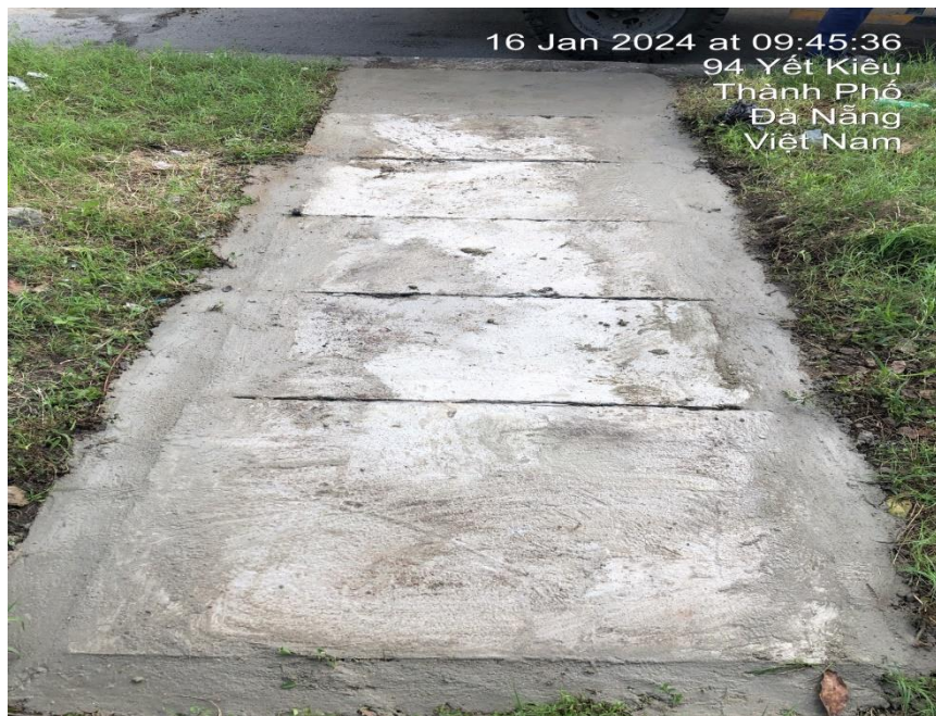
Hình ảnh sau xử lý trên vỉa hè gần số 96 đường Yết Kiêu
