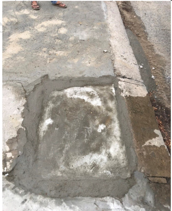
Hình ảnh trước và sau xử lý đôn hố ga bị vỡ đối diện số 188 Lý Tự Trọng
