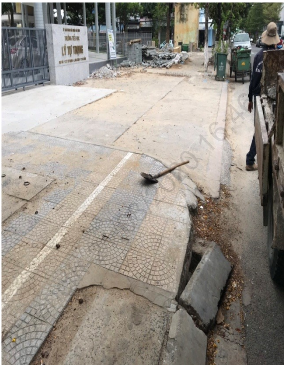
Hình ảnh trước và sau xử lý miệng cống thoát nước xuống cấp trước trường tiểu học Lý Tự Trọng
