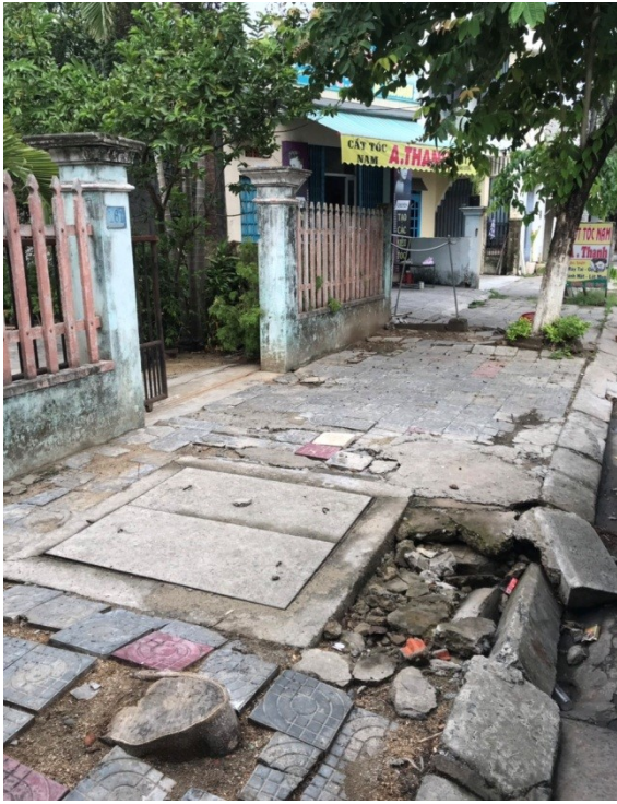
Hình ảnh trước và sau xử lý vị trí vỉa hè sụt lún trước số 161 Phạm Như Xương
