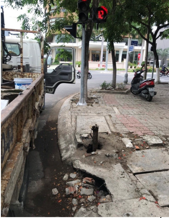
Hình ảnh trước và sau xử lý đôn hố ga bị vỡ nút đường Võ Thị Sáu – 3 Tháng 2
