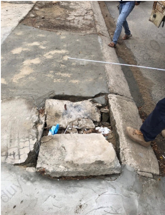
Hình ảnh trước và sau xử lý đôn hố ga bị vỡ đối diện số 188 Lý Tự Trọng
