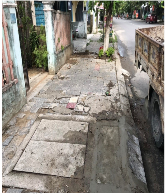
Hình ảnh trước và sau xử lý vị trí vỉa hè sụt lún trước số 161 Phạm Như Xương
