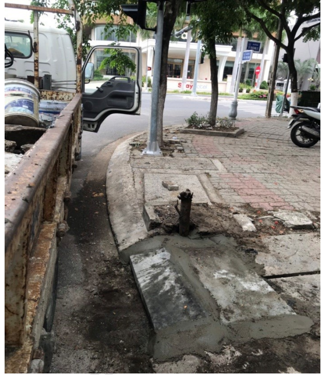
Hình ảnh trước và sau xử lý đôn hố ga bị vỡ nút đường Võ Thị Sáu – 3 Tháng 2
