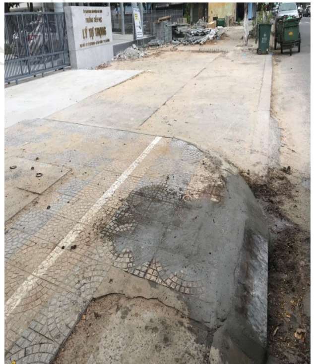
Hình ảnh trước và sau xử lý miệng cống thoát nước xuống cấp trước trường tiểu học Lý Tự Trọng
