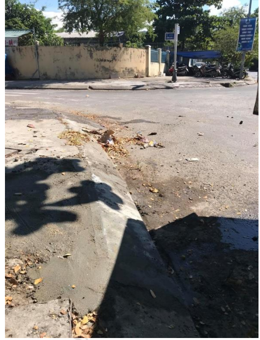
Hình ảnh trước và sau xử lý tại vị trí đan vỡ góc tuyến đường Đồng Bài 4 – Ngô Văn Sở
