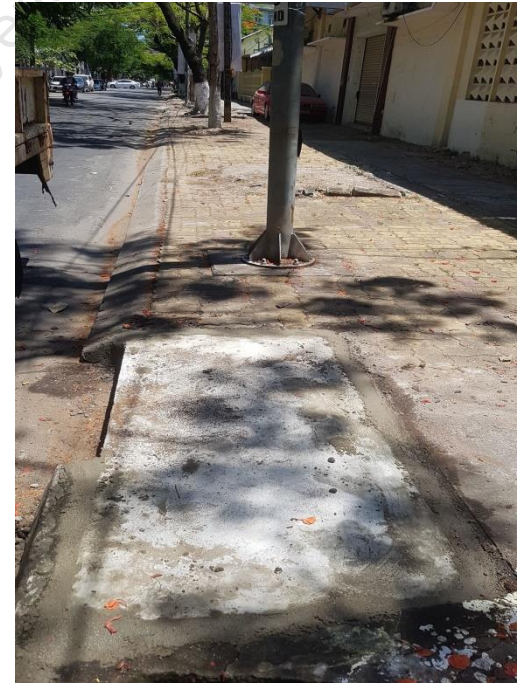
Hình ảnh trước và sau xử lý tại vị trí đan vỡ góc tuyến đường Đồng Bài 4 – Ngô Văn Sở
