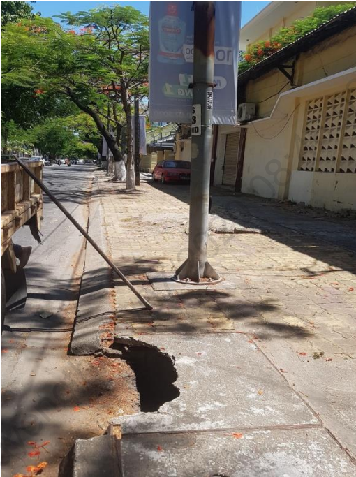
Hình ảnh trước và sau xử lý tại vị trí đan vỡ góc tuyến đường Đồng Bài 4 – Ngô Văn Sở
