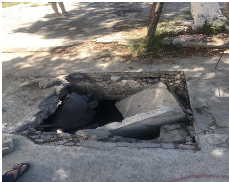
Hình ảnh trước xử lý tại vị trí đôn cống bị vỡ đầu kiệt 911 Nguyễn Tất Thành
