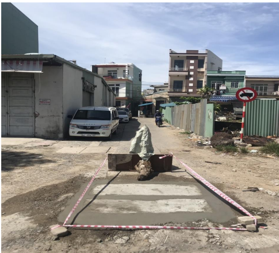
Hình ảnh sau xử lý tại vị trí đôn cống bị vỡ đầu kiệt 911 Nguyễn Tất Thành
