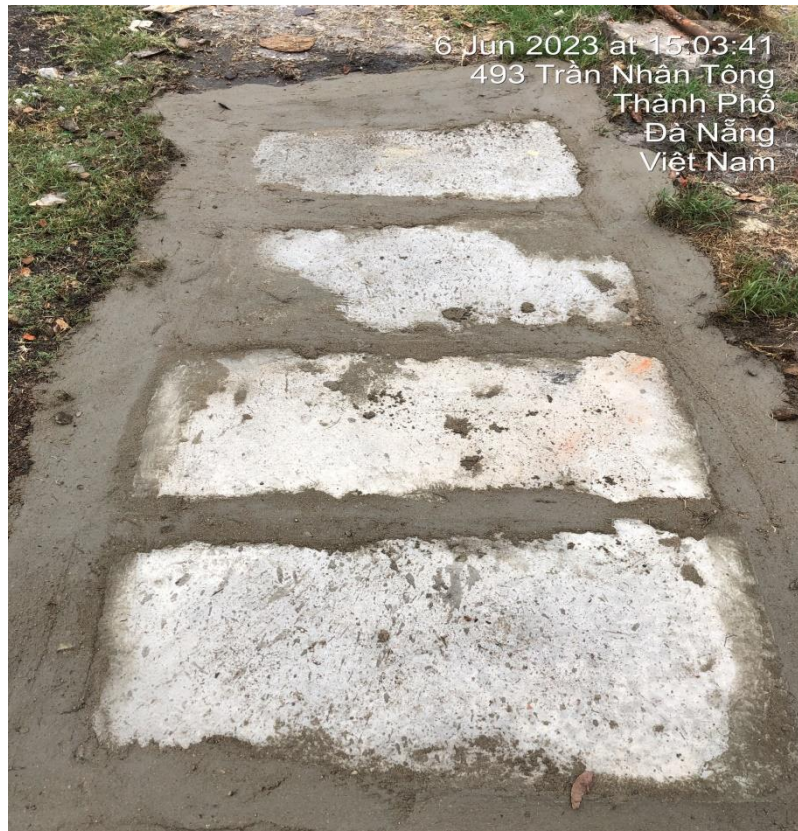
Hình ảnh sau xử lý vị trí đạn vỡ tại ngã tư Trần Nhân Tông – Tôn Quang Phiệt
