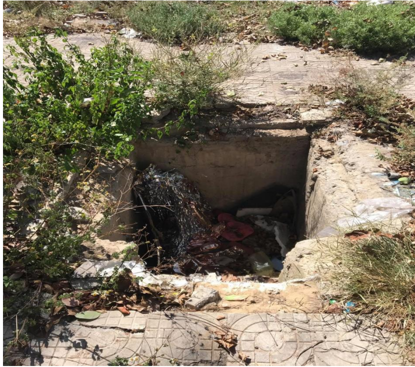
Hình ảnh trước xử lý tại hố thoát nước không nắp trên đường Chương Dương
