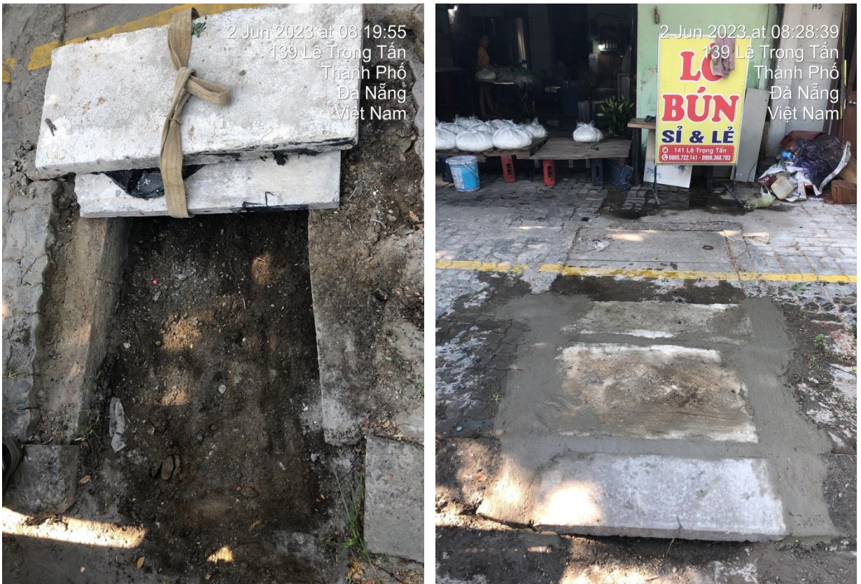
Hình ảnh trước và sau xử lý vị trí đạn hư hỏng đối diện số 141 Lê Trọng Tấn
