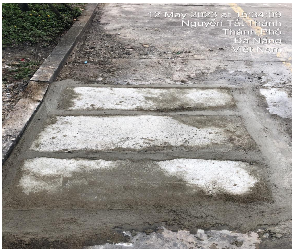
Hình ảnh sau xử lý vị trí nắp hố ga hư hỏng trên đường Nguyễn Tất Thành
