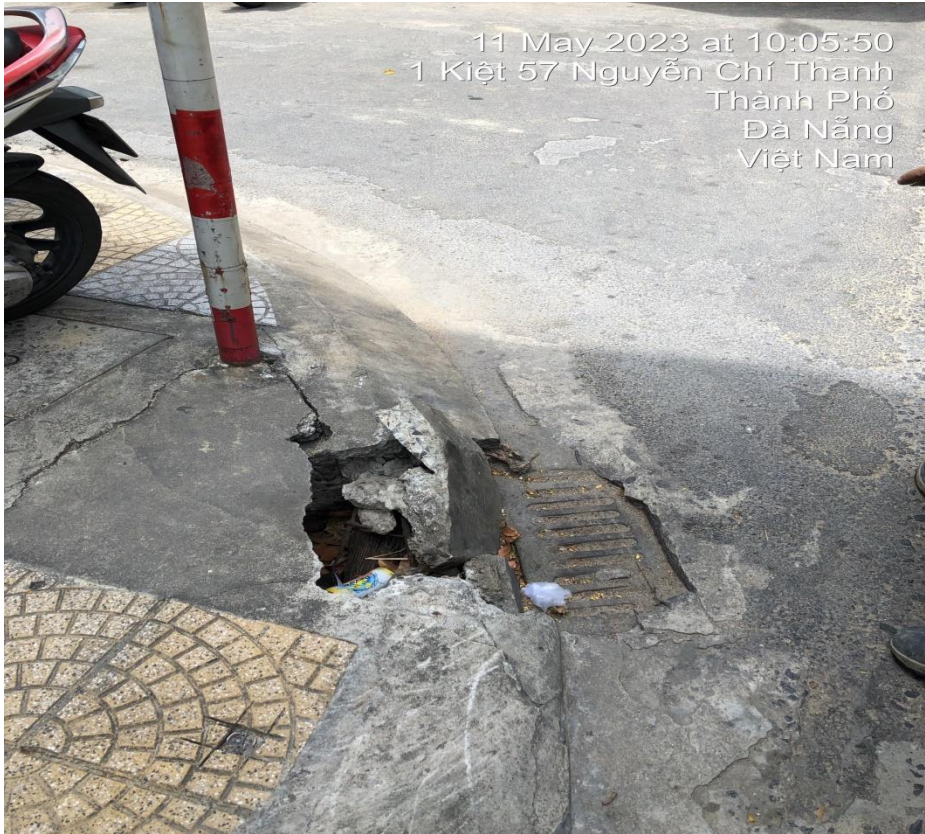
Hình ảnh trước xử lý vị trí bó vỉa hư hỏng trên đường Nguyễn Chí Thanh
