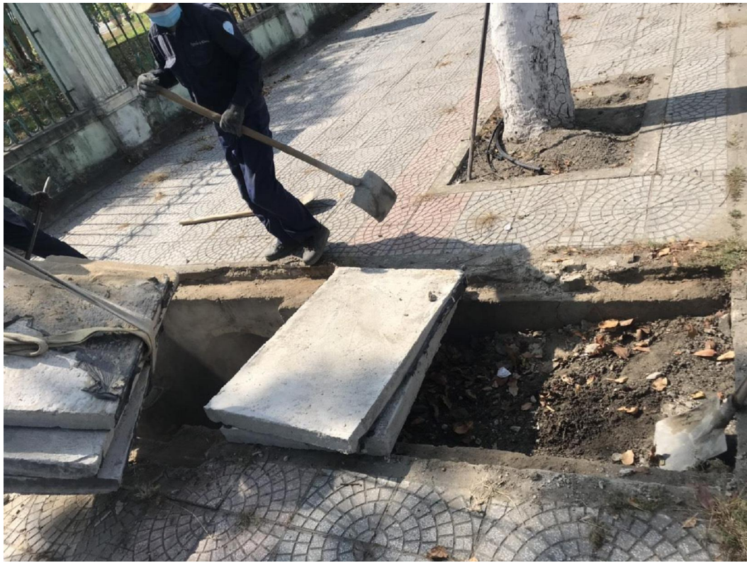
Hình ảnh trước xử lý tại vị trí hố ga bị vỡ trước số 555B Trường Chinh
