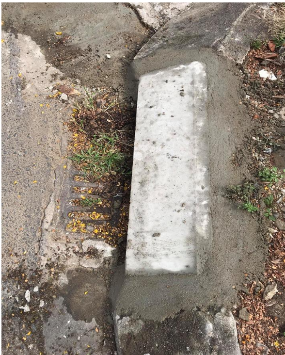
Hình ảnh sau xử lý tại các vị trí đan hư hỏng trên đường Dũng Sĩ Thanh Khê
