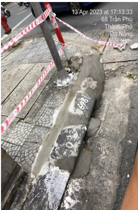
Hình ảnh bó vỉa đã được sửa chữa tại ngã tư Trần Phú – Phan Đình Phùng
